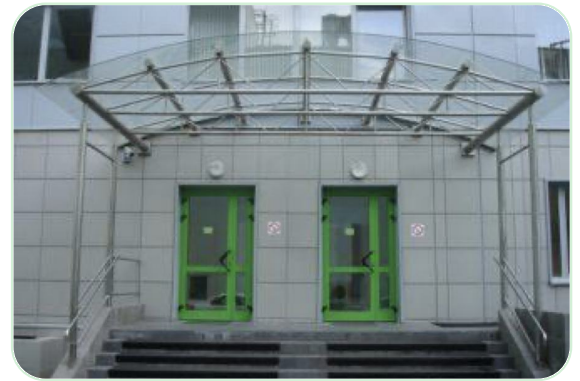
Фото 1. Приклад навісу над майданчиком перед входом у будівлю.
